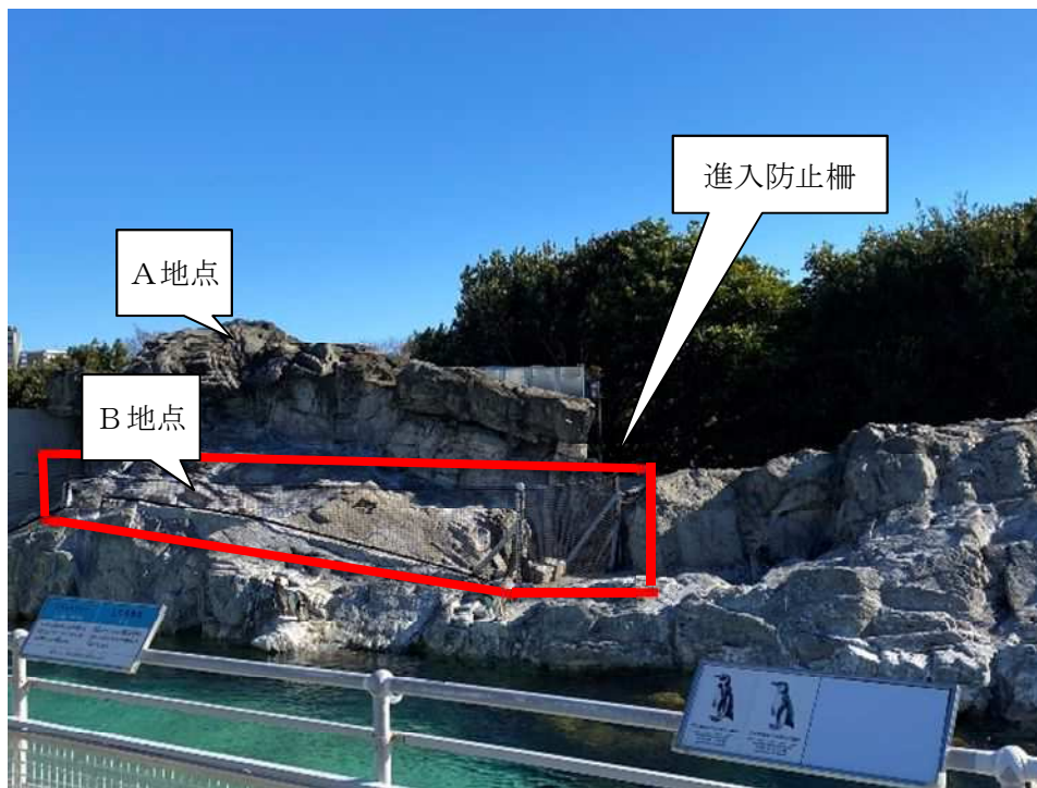
(写真2) ②工事によるペンギン等進入防止柵の設置状況
