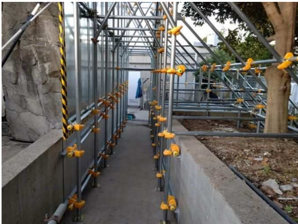
(写真3) ③工事による塀裏面の管理用通路における補強状況
