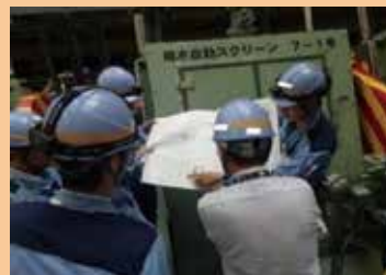
工事監査の様子
